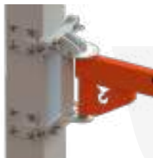
Staffe con fissaggio chimico laterale
