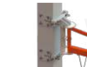
Staffe con fissaggio chimico laterale
