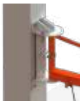
Fissaggio chimico frontale
