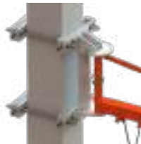
Fissaggio con controstaffe e tiranti
